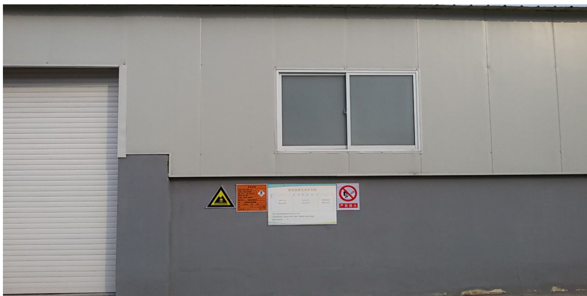
图 4.6 本项目危废暂存仓库
