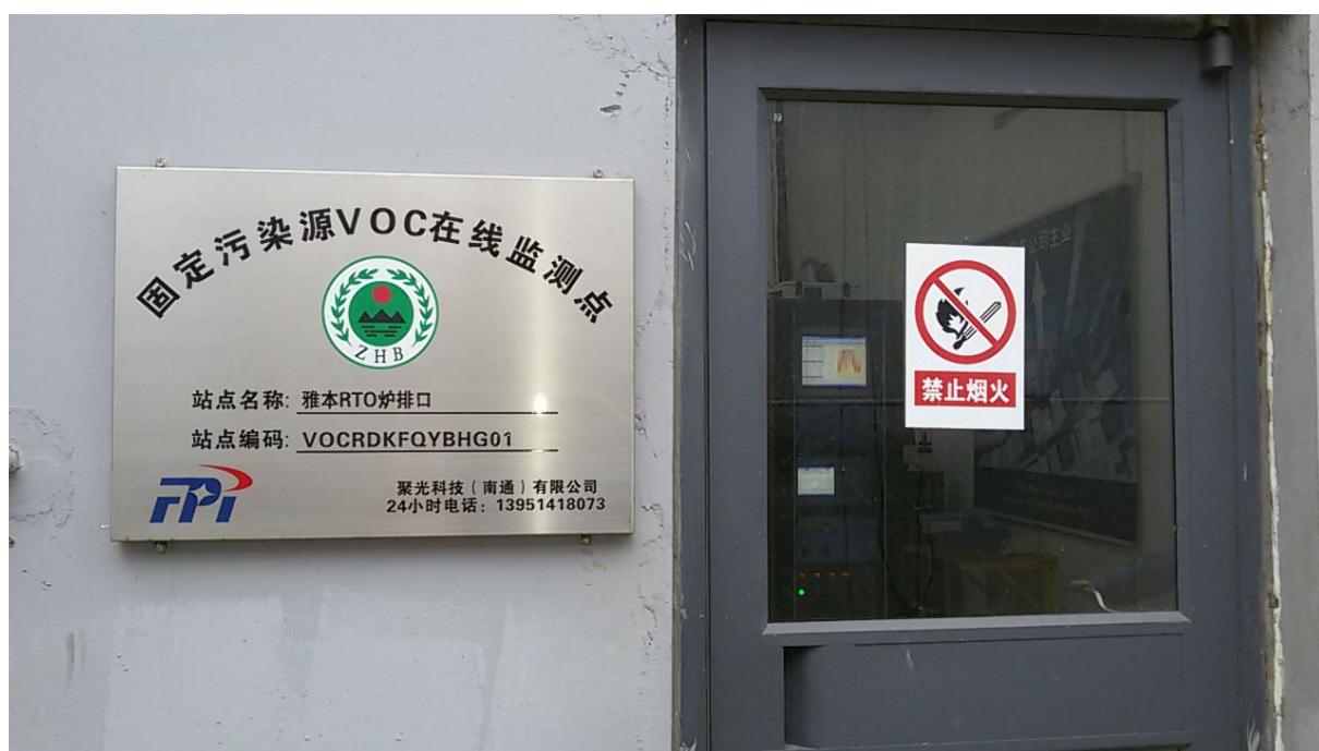
图 4.8 本项目废气在线监测设施
