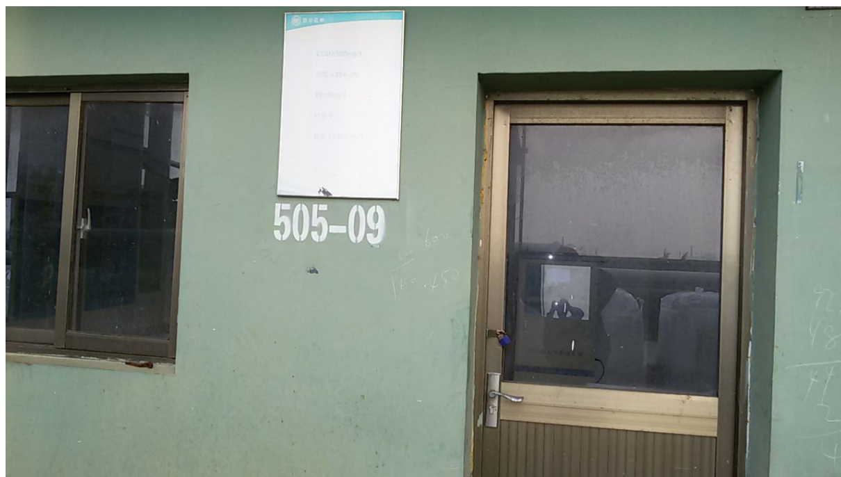
图 4.7 本项目废水在线监测设施
